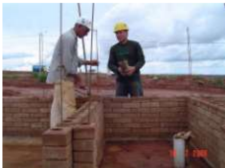
Fig.5: Residência em construção com tijolos ecológicos.
