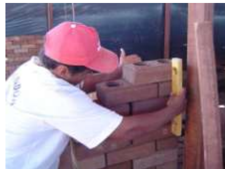
Fig.6: Processo de execução da alvenaria.
