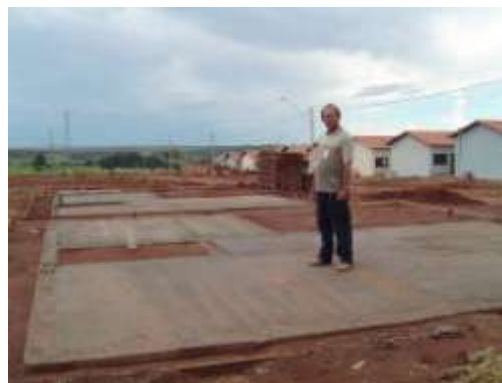
Fig.2: Lotes da Quadra 10 com as bases preparadas.
