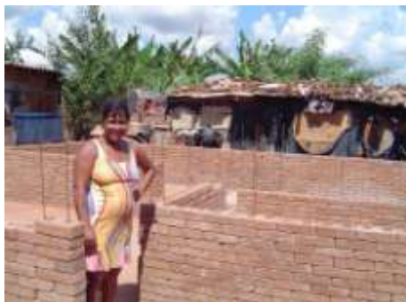
Fig.21: Casa da Marlene em construção. Ao fundo a casa onde a família vive.
