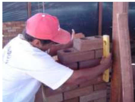
Fig.6: Processo de execução da alvenaria.
