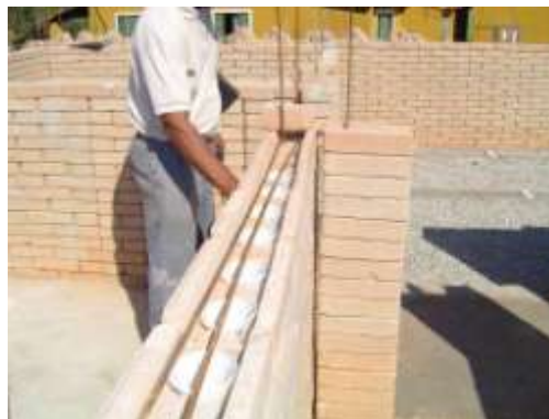
Fig.24: Projeto Lua Nova: casas em construção
