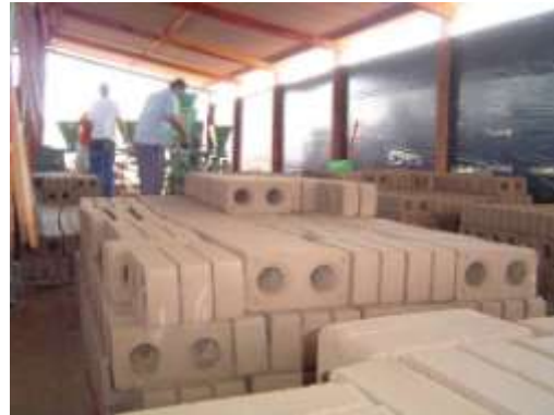
Fig. 4: Barracão e prensa para a fabricação dos tijolos e peças prontas.
