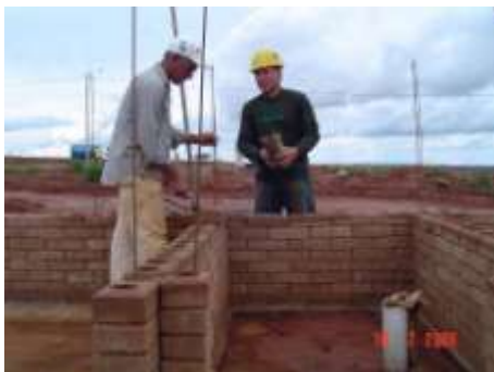
Fig.5: Residência em construção com tijolos ecológicos.
