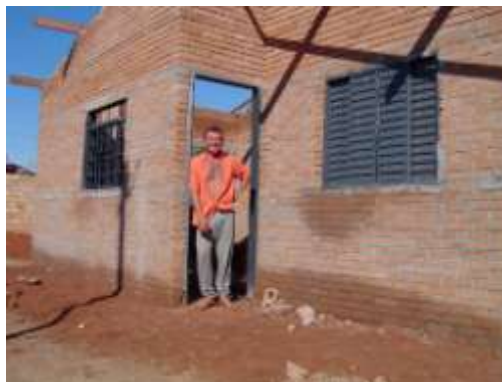
Fig.16: Casa do Ronaildo em execução.
