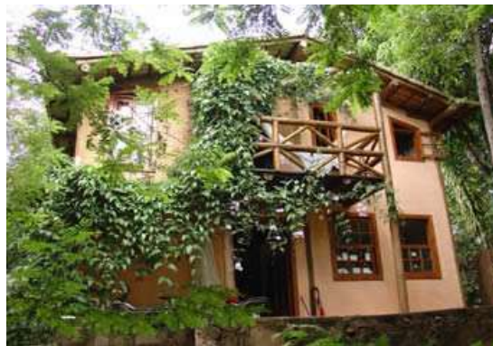
Fig.30: Casa em Lençóis (BA). http://www.vilaserrano.com.br/portugues/construcao.htm
